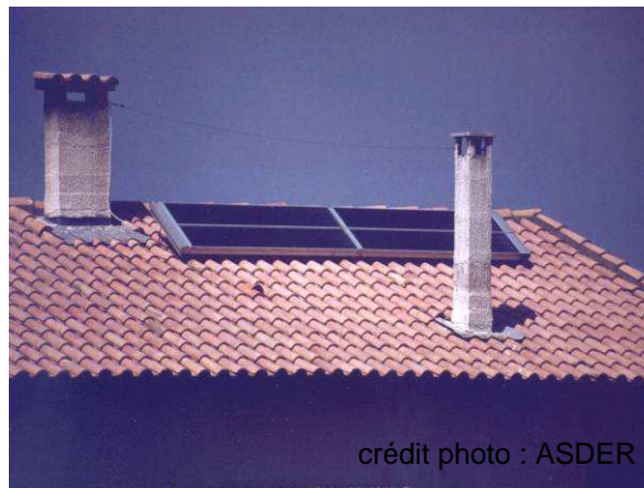
Capteurs posés sur toiture
