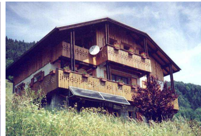
Capteurs intégrés en allège de balcon
