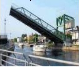
Position du pont
